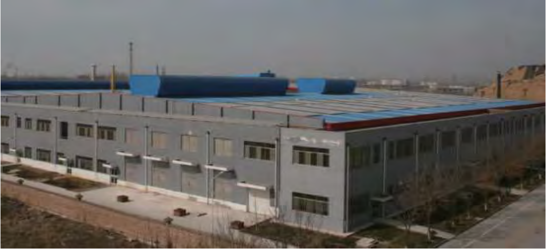
7#厂区 3.5MWp 光伏屋顶分布式发电项目图片
